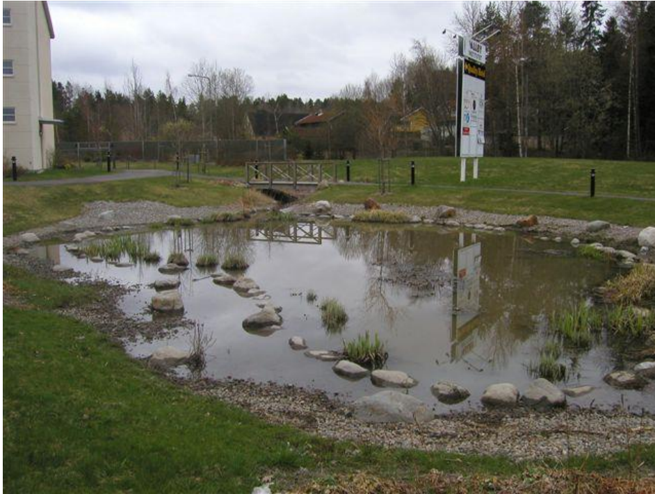
Figur 30. Exempelbild våt damm (Foto: Sweco).
