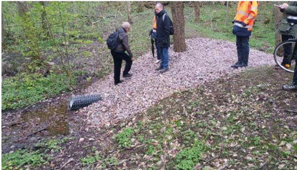
Figur 36. Exempel på jordvall, genomförd skyfallsåtgärd i Guldhedsdalen, Göteborg (Kretslopp och Vatten, 2021) Foto: Kretslopp och Vatten.
