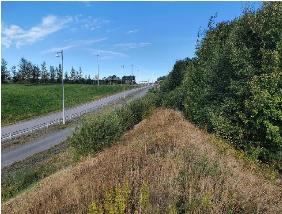
Figur 7. Gångbana och Trafikverkets dike väster om planområdet.
